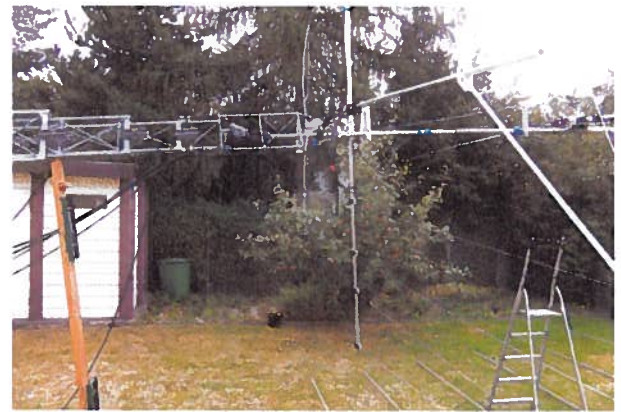
Blick auf die Antennenhalterung, hier befestigt am umgekippten Versatower BP60 vor dem Wohnhaus
